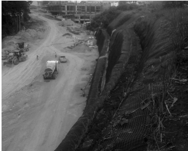
Figura 9: Taludes protegidos con manto y sistema vetiver
