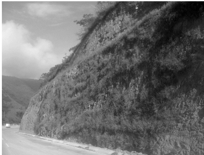
Figura 2: Protección de talud de corte con hidrosiembra
