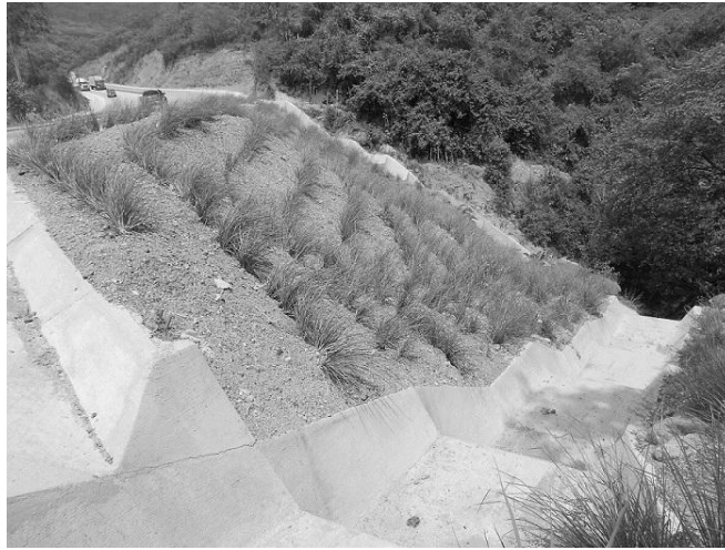
Figura 3: Talud de relleno protegido con Sistema vetiver
