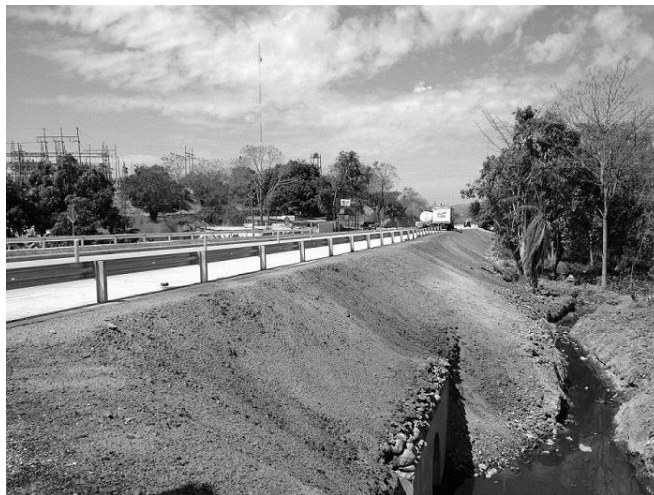
Figura 4: Talud protegido con hidrosiembra
