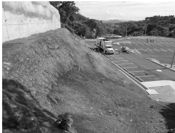
Figura 8: Hidrosiembra protegiendo talud de parqueo
