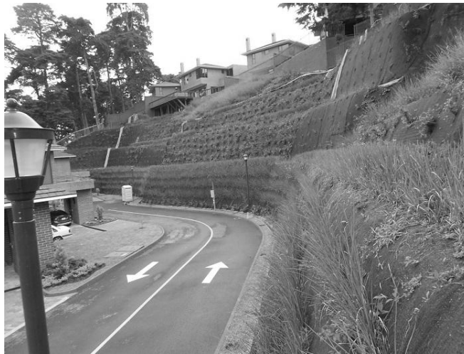
Figura 5: Protección de taludes con manto y sistema vetiver
