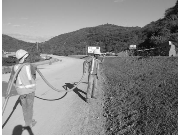
Figura 8: Aplicación de Hidrosiembra
